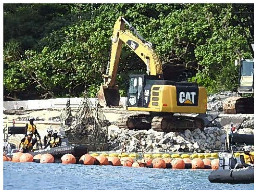
5/15 辺野古沿岸、護岸工事のため、石材が波打ち際に次々と投下されている。 【沖縄タイムスプラス 2017/05/15】
