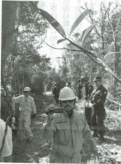
G地区から宇嘉川河口までの歩行訓練ルート を歩いた。工事は、機動隊と防衛局職員がガ ード。ルートには橋を架け、階段まで作る計画だ =2016年11月5日
